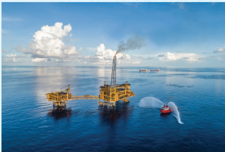
Hình 1: Giàn đầu giếng và xử lý trung tâm mỏ Hải Thạch (WHP & PQP-HT)
