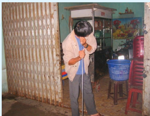
Hình 1. Nghe rò rỉ trên ống nước bằng ống nghe vào ban đêm
